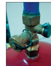
Многофункциональная арматура для расширительного бака
